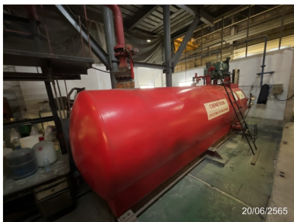
รูปที่ 3-7 ถังเก็บก๊าซคาร์บอนไดออกไซด์
