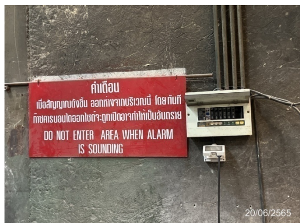
รูปที่ 3-9 จุดปล่อยก๊าซคาร์บอนไดออกไซด์ดับเพลิงและป้ายเตือนการใช้ถังเก็บก๊าซคาร์บอนไดออกไซด์
